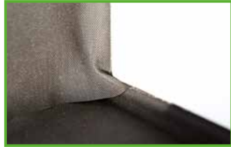
Situation ohne DEFLEX®-Versiegelungsecken. Anwendung schwierig abzudichten.
