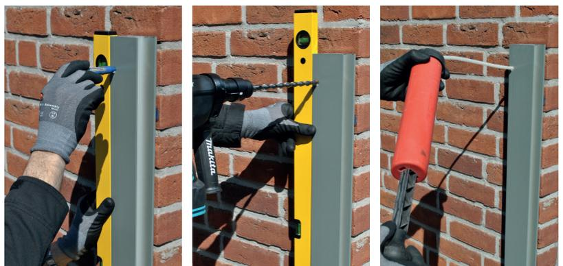
Die Auflage- und Bodenfläche der Wandschienen wird nun mit einem geeigneten Kleb- und Dichtstoff in ausreichender Menge versehen. Mit dem Befestigungsmaterial können nun die Wandschienen im Lot fest mit der Wand verschraubt werden.
