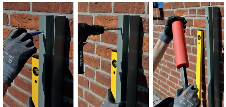
Die Auflage- und Bodenfläche der Wandschiene wird nun mit einem geeigneten Kleb- und Dichtstoff in ausreichender Menge versehen. Mit dem Befestigungsmaterial können nun die Wandschienen im Lot fest mit der Wand verschraubt werden.
