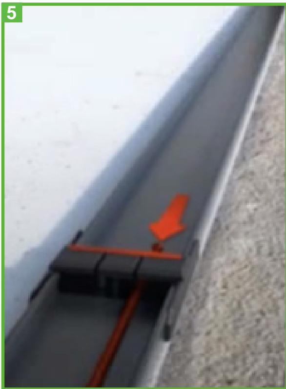
6. Umlenker und Fadenspanner durch die Stanzung im Kopfprofil einführen (je Seite eine Stanzung je Gewebepaket).
