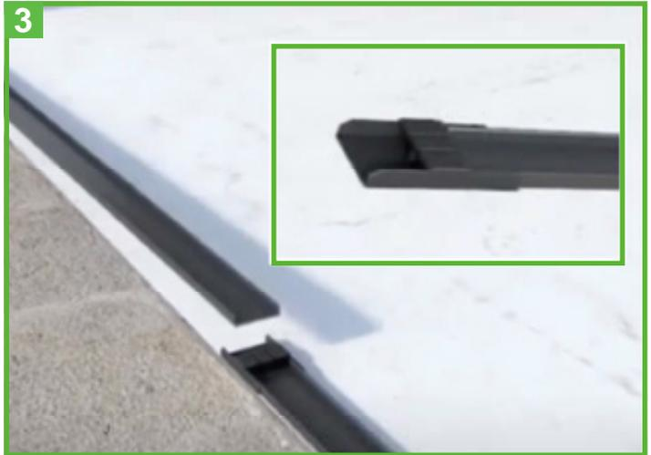
4. Gewebepakete in die Seitenprofile einsetzen.
