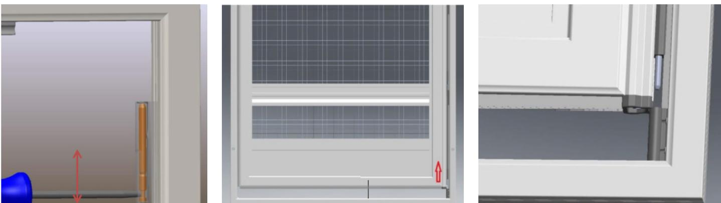
Nach dem Entriegeln des oberen Scharniers in gleicher Weise die mittleren Scharniere entriegeln. Der Türflügel kann nun leicht schräg angesetzt nach oben aus dem Einbaurahmen gezogen werden.
