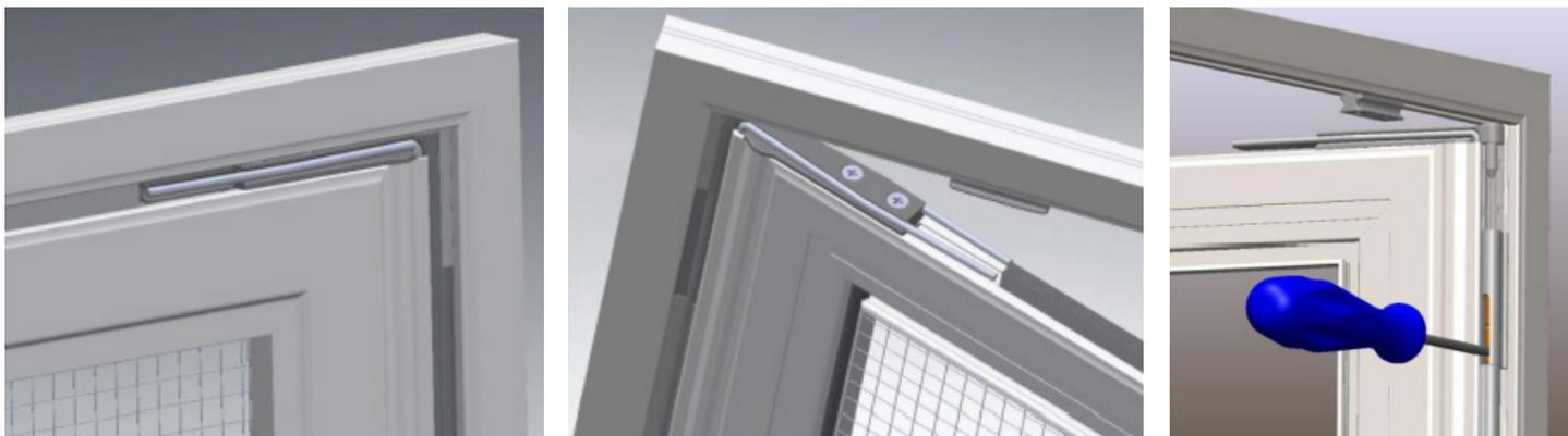
Zum Ver- oder Entriegeln des oberen Scharniers und der mittleren Scharniere sollte generell der mitgelieferte Spezialschlüssel verwendet werden. Alternativ kann auch ein Innensechskantschlüssel SW2 oder Torx TX8 verwendet werden.
