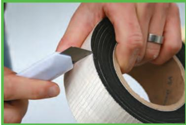
Die Fugenbreite ergibt sich aus dem tatsächlichen (max.) Abstand zwischen Außensteg und Mauerwerk. Dabei sind die Herstellervorgaben zum Einsatzbereich unter Berücksichtigung von temperaturbedingten Längenänderungen bzw. Bauteilbewegungen zu beachten.
