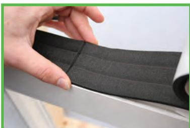
Blendrahmen mit Systemband in die Maueröffnung stellen, Löcher vorbohren und mit handelsüblichen, lastabtragenden Distanz-Befestigungs-Schrauben montieren.
