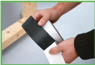
Abdeckpapier ca. 20 cm entfernen. Band mit Überstand (unteres Fugenbreitenmaß) auf den Blendrahmen kleben.
