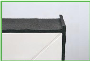
Band in der oberen Ecke mit Überstand (oberes Fugenmaß) abtrennen und bündig mit der Blendrahmenaußenkante in der Ecke stumpf stoßen.
