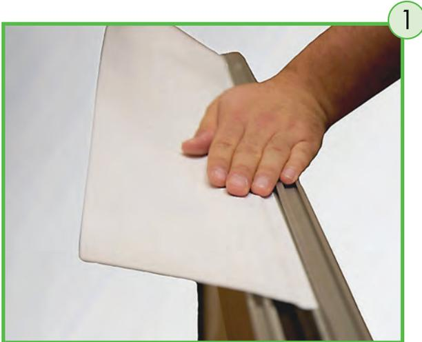
DEFLEX®-Fensterflex-Folie je nach Einbaulage auf der Stirnseite oder der Außen/Innenseite des Blendrahmens anbringen.
